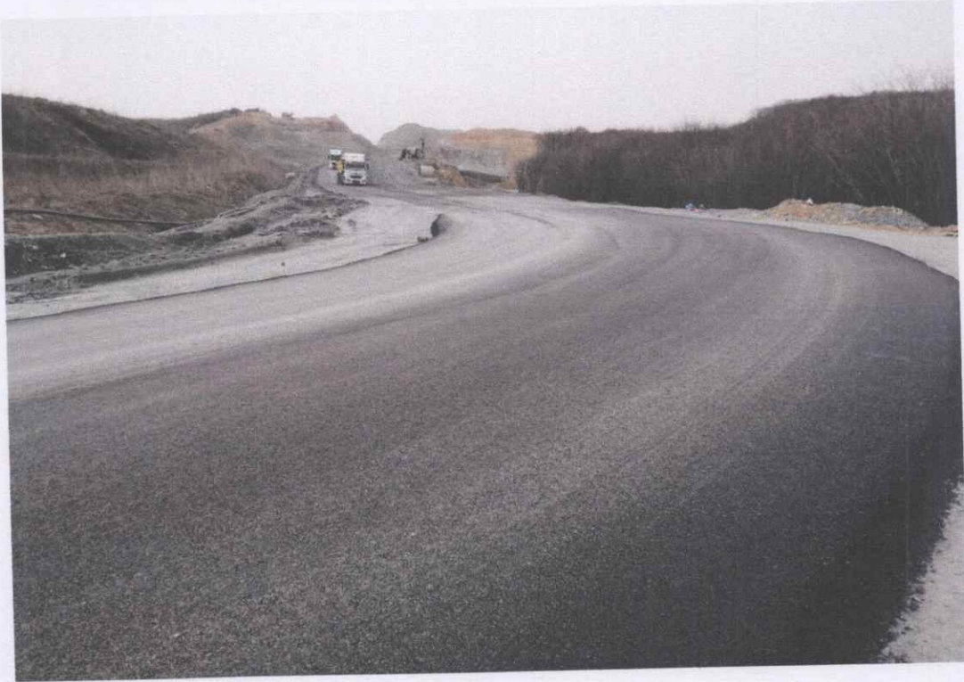
Görsel-20: Ocak Alanı ile Ana Yol Arası Asfalt Çalışmaları
