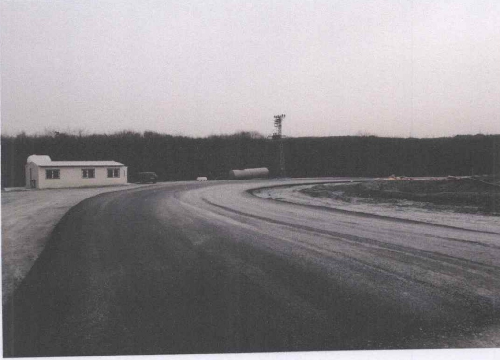
Görsel-25: Ocak Sahası İle Ana Yol Arası Asfalt Çalışması
