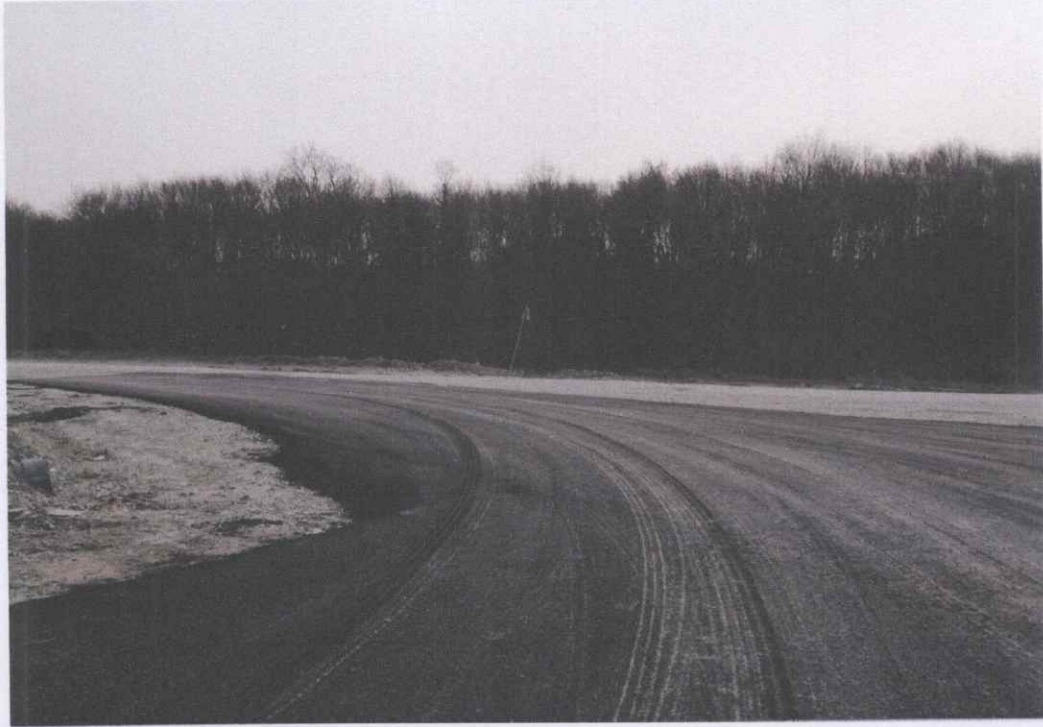
Görsel-22: Asfalt Çalışması-Ana Yola Çıkış Noktası
