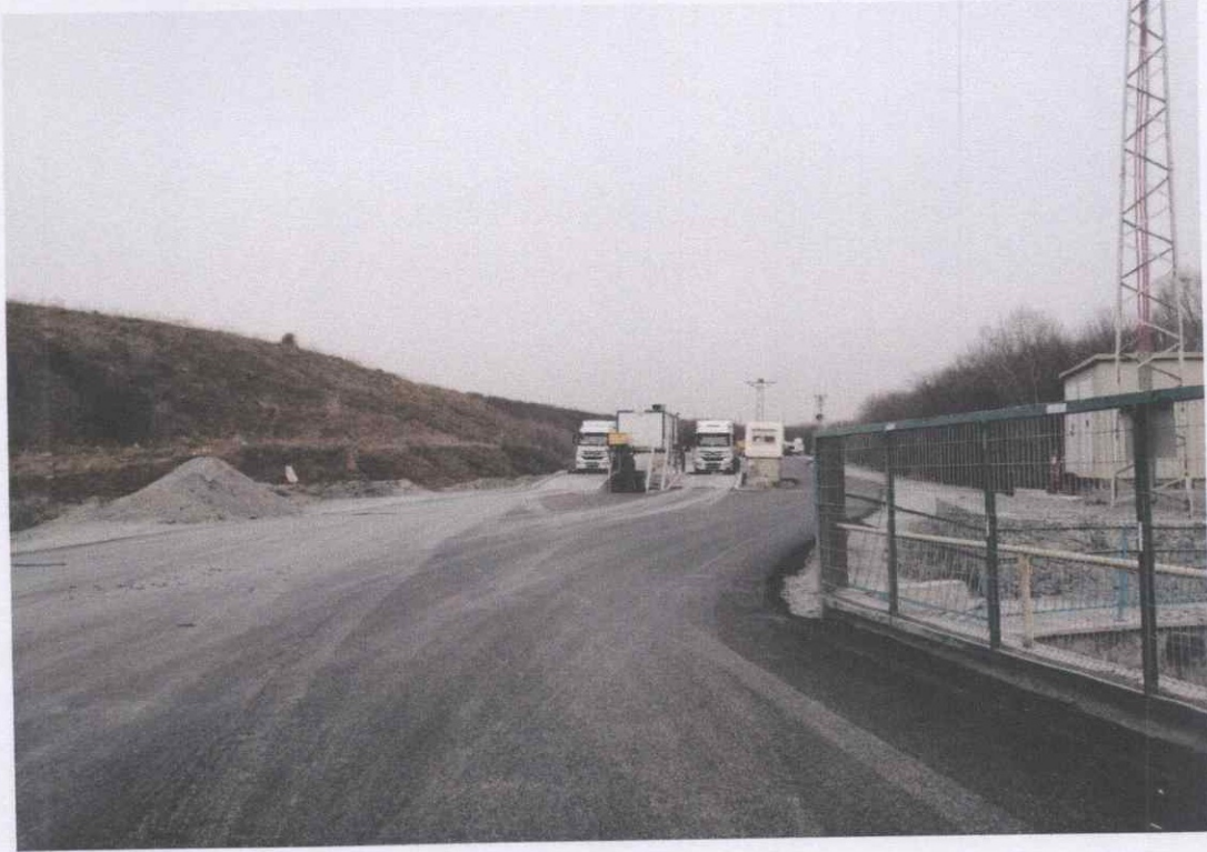
Görsel-24: Asfalt Çalışması-Tesis Giriş Noktası
