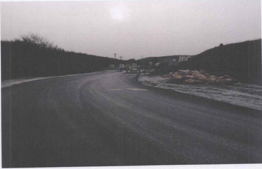
Görsel-19: Ocak Alanı ile Ana Yol Arası Asfalt Çalışmaları
