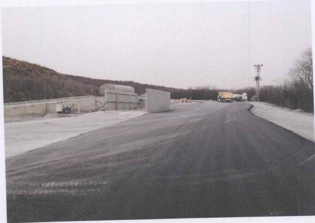
Görsel-28: Araç Lastik Yıkama Alanı Bölgesi Asfalt Çalışmaları
