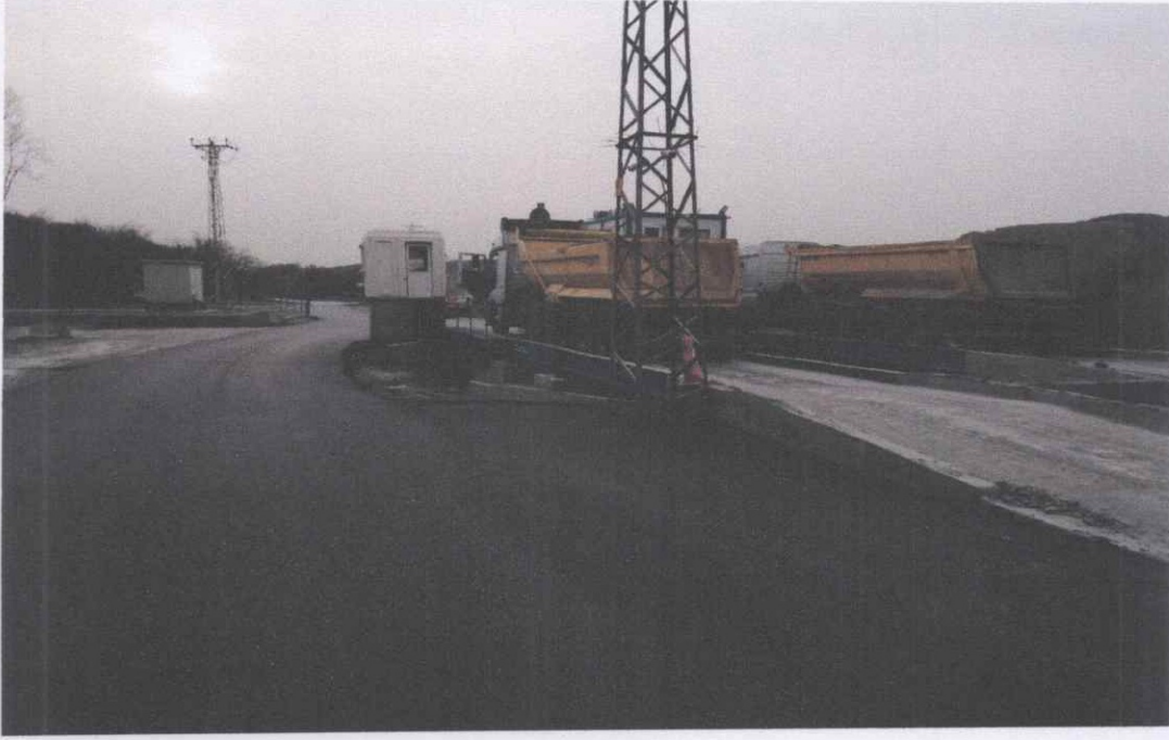
Görsel-23: Asfalt Çalışması-Kantar Bölgesi
