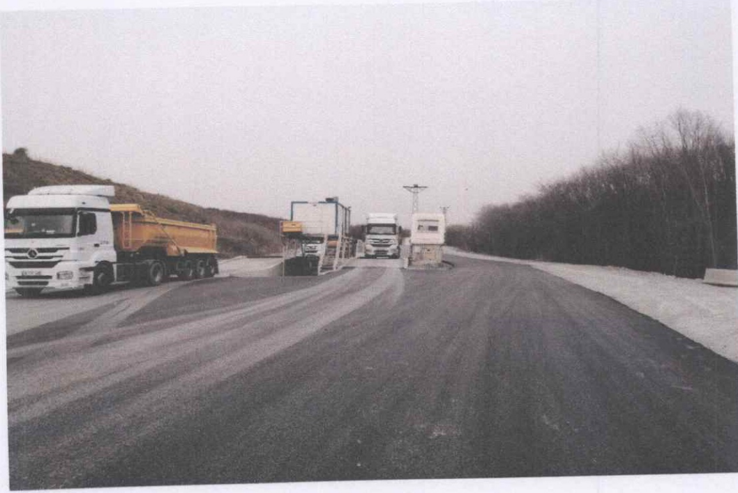
Görsel-27: Kantar Bölgesi Asfalt Çalışması
