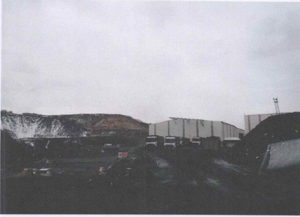
Görsel-3: Kırma-Eleme Tesisi Genel Görünüm
