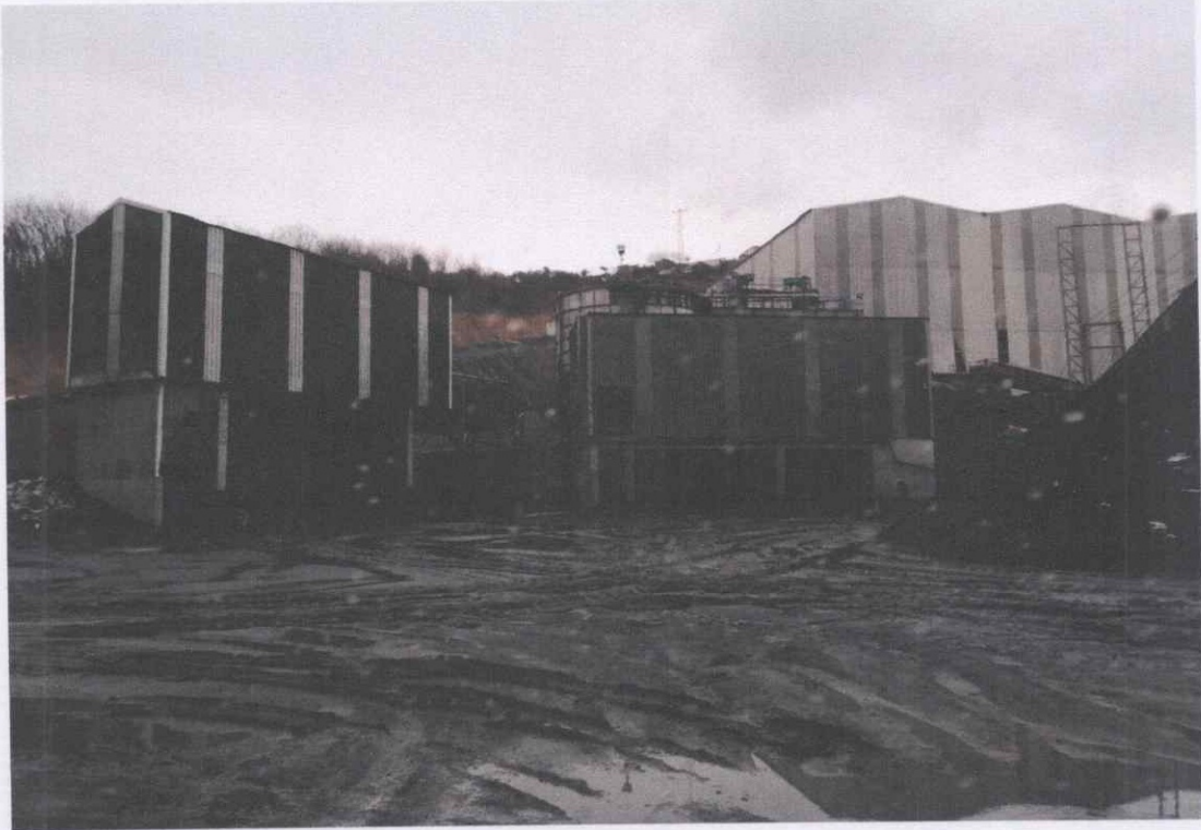
Görsel-12 Yıkama Tesisi ve Filtrepress Üniteleri(Tamamen Kapalı Alan)
