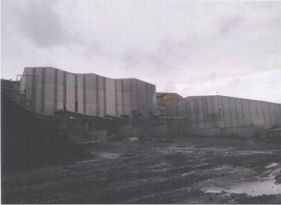
Görsel-4: Kırma-Eleme Tesisleri Genel Görünüm
