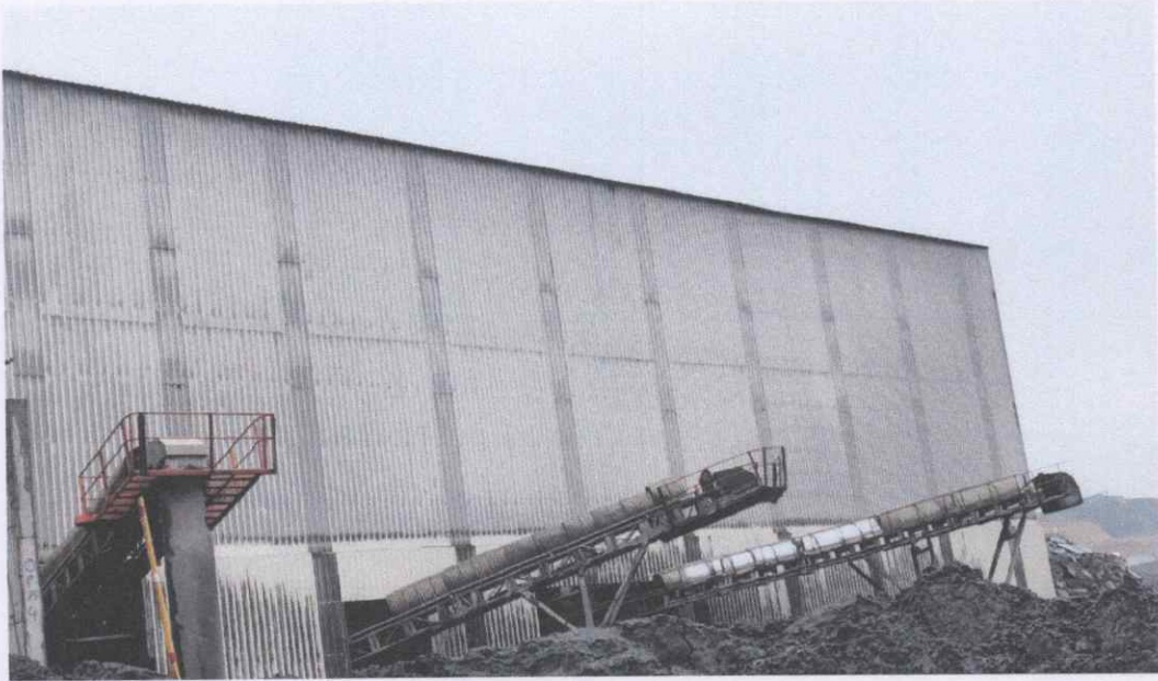
Görsel-10: Kırma-Eleme Tesisi Bant Kapamaları
